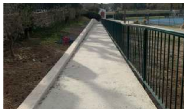
Rampe ERP PMR Stade Municipal
