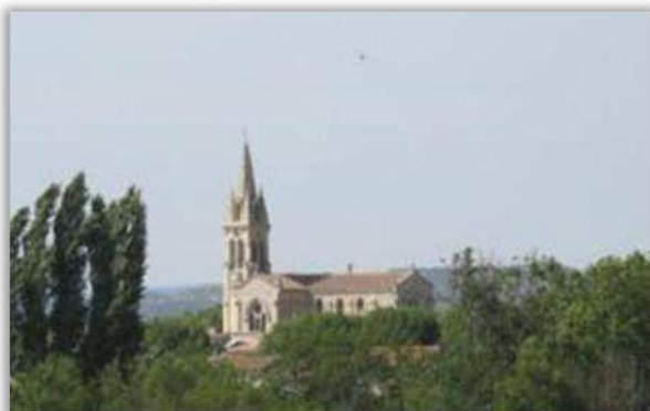
Photographie de l'église de Saint-Cannat (Source : CITADIA)
