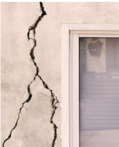
Le RGA, retrait/gonflement des argiles, est le deuxième aléa le plus fréquent après les inondations. C'est un phénomène dont les victimes ont du mal à se faire indemniser. Ces gonflements des argiles engendrent des mouvements de terrains qui abiment les structures des habitations, avec des dégâts allant de fissures jusqu'à des effondrements.
