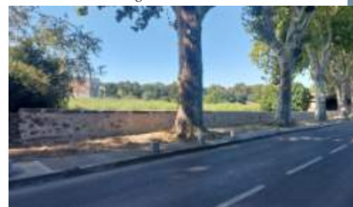
Mur Avenue Pasteur
