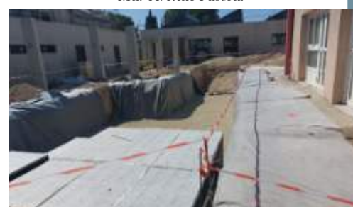
Travaux école - Bassin de Rétention
