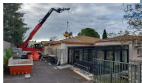
Toiture Ouest de la Crèche
